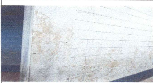
Foto7: Pintura exterior e interiores de las aulas 1,2,3,4.
